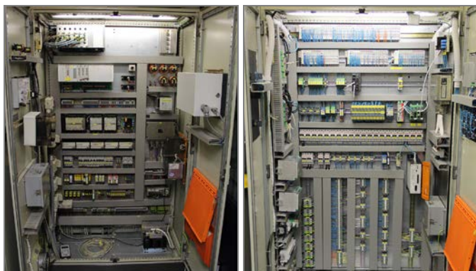
Alt vs. neu: Links der alte Schaltschrank. Da der alte Schaltschrank nicht aufgerüstet werden konnte, musste vor Ort ein neuer eingebaut werden. Rechts der neue Schaltschrank.
