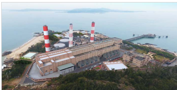
Rendering des künftigen, erweiterten Kraftwerks Ta-Shan, Insel Kinmen, Taiwan, Republik China
