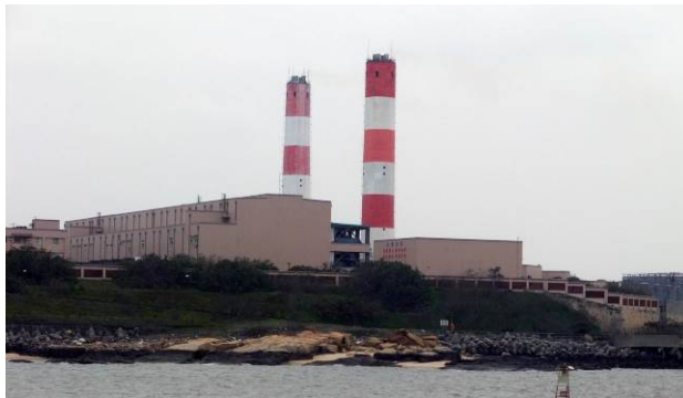
Kraftwerk Ta-Shan, Insel Kinmen, Taiwan, Republik China im derzeitigen Zustand
